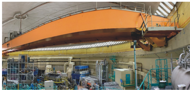
Remplacement du charriot et renforcement du pont polaire du niveau D du bâtiment réacteur.
