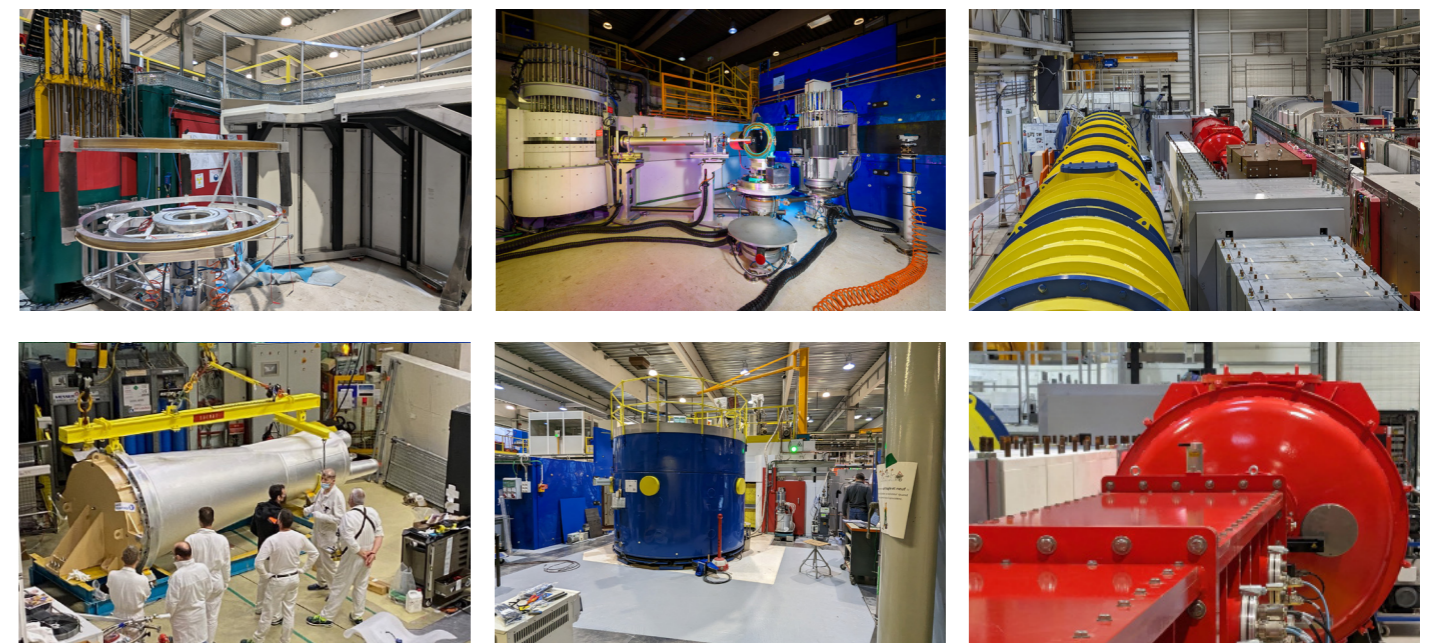
Remplacement du guide H1-H2 (en bas à gauche), essentiel pour l'installation de nouveaux instruments scientifiques améliorés dans le cadre du programme Endurance.
