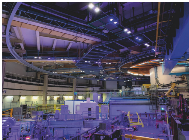
Installation d'un système de sprinkler au niveau C du bâtiment réacteur.
