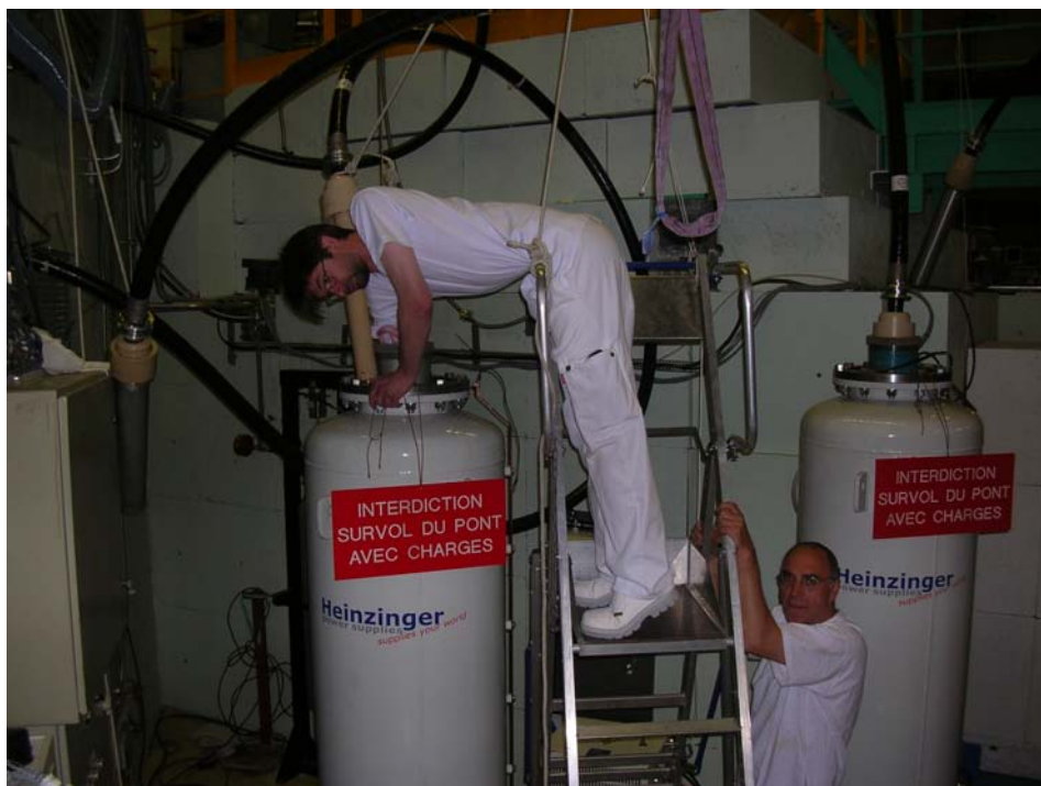
FIG. 6.1 – Thomas Materna (gauche) et Herbert Faust (droite) pendant la réparation d'une des résistance du générateur de haute tension.
