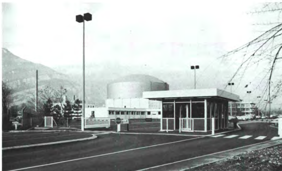
Nouveau poste de garde à l'entrée du site de l'ILL.
