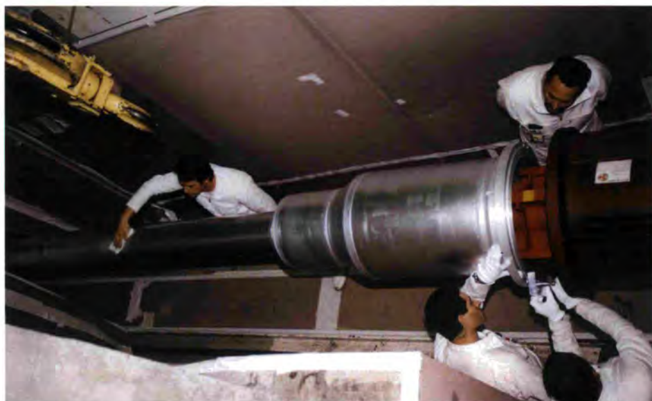
Preparing the H10 guide for replacement (N. Laurens, M. Samuel and N. Della-Gatta).
